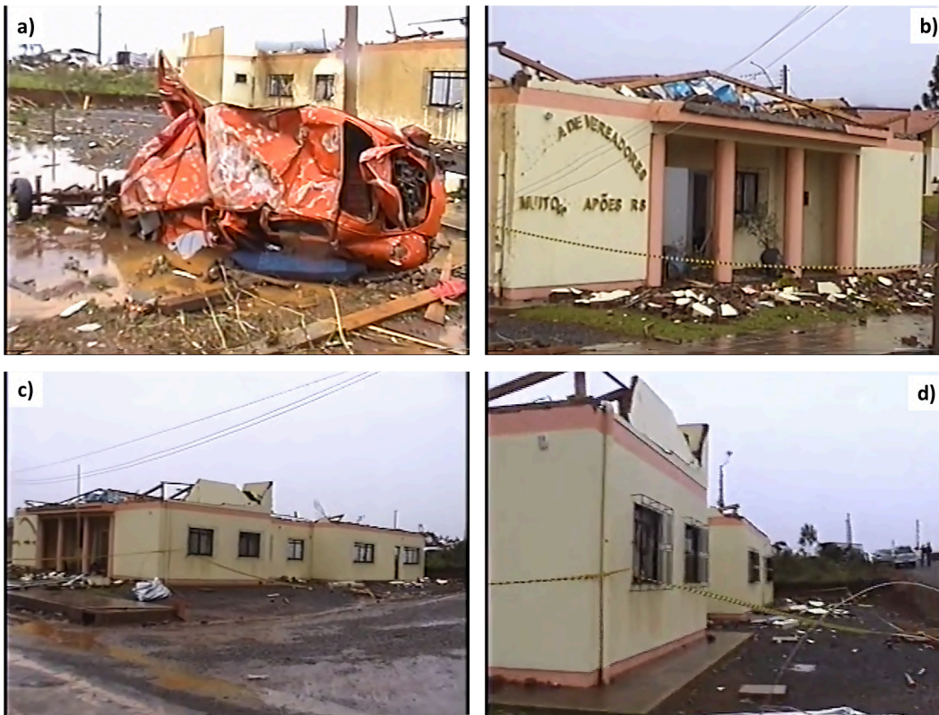
Figura 14 - Imagens de danos em construções presentes na visada C mostrada na Figura 10, obtidas do material em vídeo.
