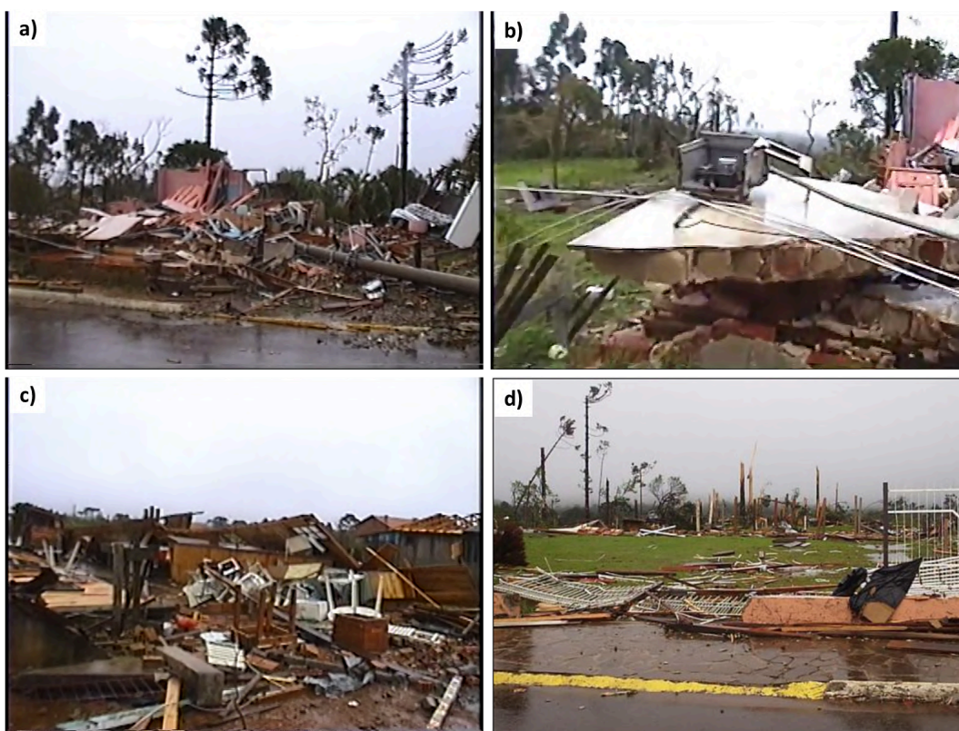
Figura 19 - Imagens de danos em construções na Av. Progresso presentes na visada F mostrada na Figura 10, obtidas do material em vídeo.
